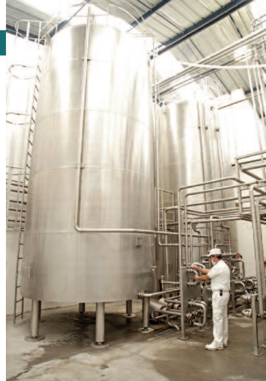
ARRIBA: Máquinas de envasado de leche en empaques tetrapack en El Ordeño S. A. DERECHA: Tanques de enfriamiento de leche de la misma empresa.
