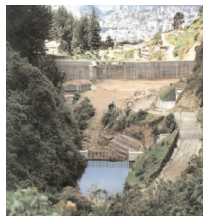
Muro y presa en la quebrada Rumipamba "Proyecto laderas del Pichincha".
