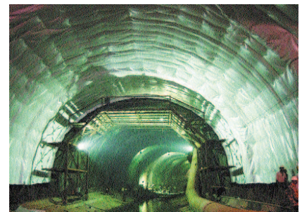
Túneles en el cerro Santa Ana.
